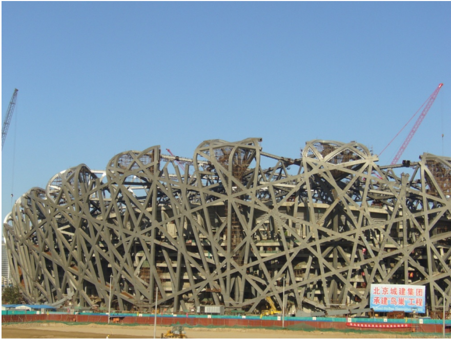
2008北京奥运开闭幕式主场馆“鸟巢” 施工中实拍照片
